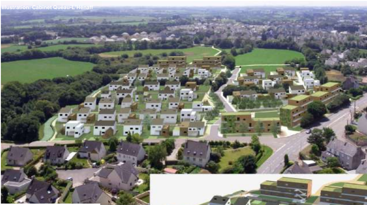
Vue aérienne depuis le Nord-Ouest
