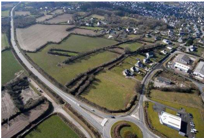
Vue oblique depuis le Nord-Est de la ZAC
